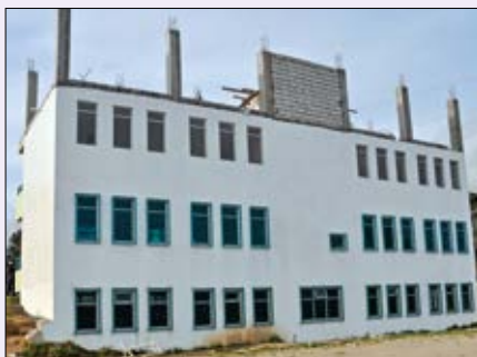
Det trengs fortsatt penger til å fullføre øverste etasje på det nye undervisningsbygget.
